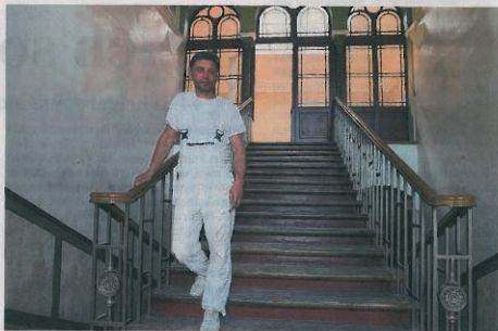
Der Hausherr: Restaurator Thomas Lauth ist mit den Arbeiten am Altenhainer Schloss fast fertig. Foto: Klaus Peschel
